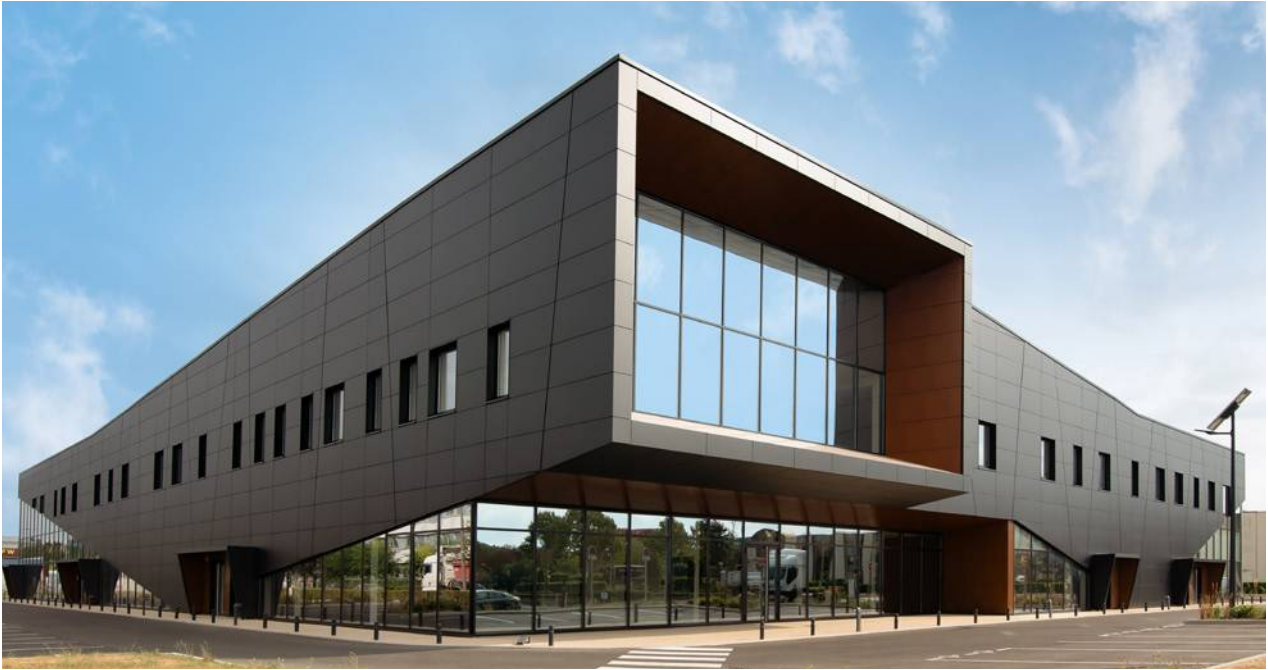
Bonneuil Sur Marne | office complex | France | STB-425
